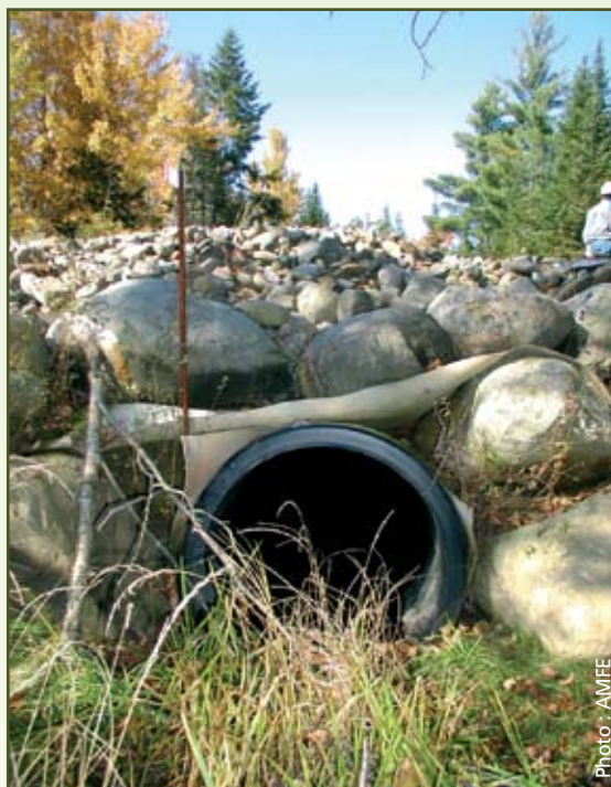
Stabilisation des extrémités du ponceau et du talus par enrochement.
